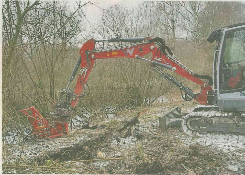
Mit einer Astschere, die an einen Kleinbagger montiert ist, wird das wuchernde Buschwerk von den Moorflächen entfernt.
