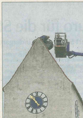
Reisigtransport per Hubsteiger.
